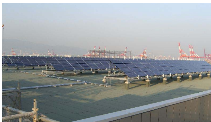
太陽光発電パネル(屋上)
